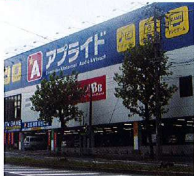
大型壁面サイン。自社ネットワークを活用し、各地への店舗展開も、ご対応いたします。
